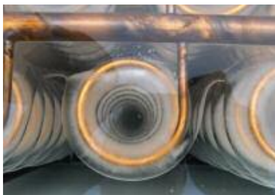
Ice Bear technologie à London (Ontario) : De grosses bobines de cuivre nous montrent comment les blocs de glace sont produits la nuit, pour refroidir l'air expulsé durant la journée.
